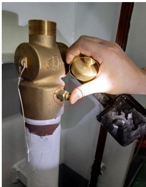
图-5 燃油舱(柜)测量管端部装置
