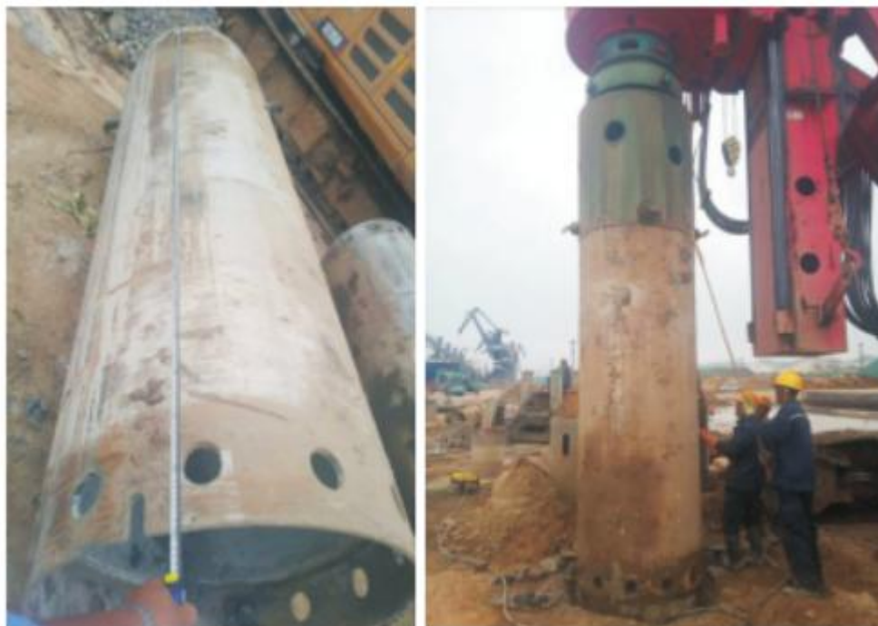
图 2 双壁护筒标准节及护筒与钻机连接示意图
