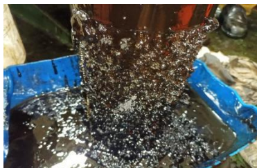
图 1 燃油驳运泵滤器状况
