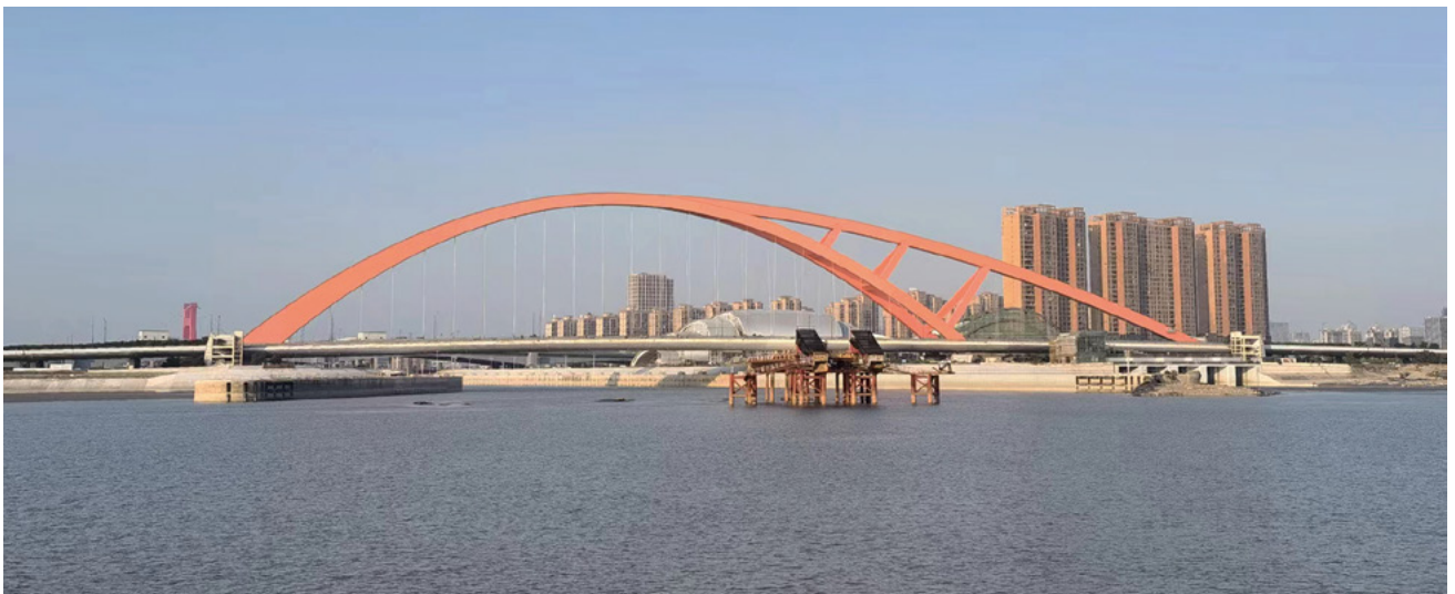
京杭运河二通道口门实景
