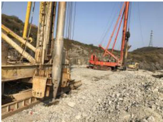
图2 设备示意图(左为引孔机,右为碎石桩机)
