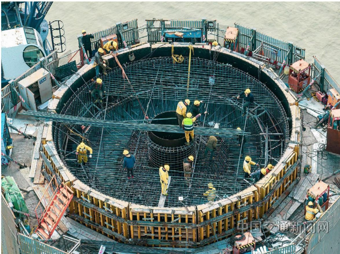
近日，在黄茅海跨海通道黄茅海大桥东主塔上，工人正在绑扎钢筋
