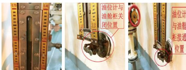
图 49-50 非自闭式控制旋塞的平板玻璃液位计
