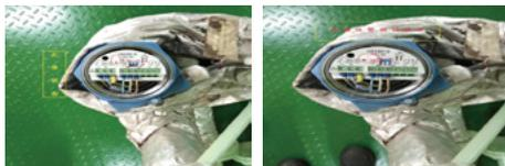
3.3.2 通过真正往收集漏油的装置中添加燃油/水, 使装置发出声光报警; 这样才真正能检测到收集漏油的装置中各个部件以及系统的好坏情况(若检查时间以及设备拆装许可, 应尽可能使用此方法)。
