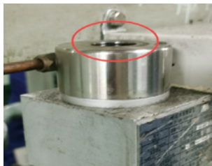
图 9 监测孔无取样水流出
