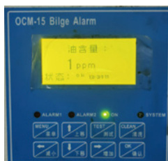
图1 经过冲刷后的清水检测仪表
